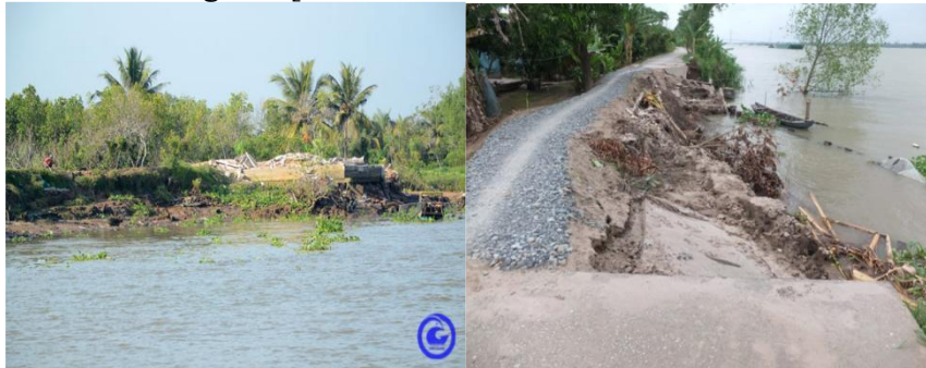
Hình 1. Sạt lở cù lao Tân Phong (trái), Sạt lở đê bao cồn Ông (phải).
