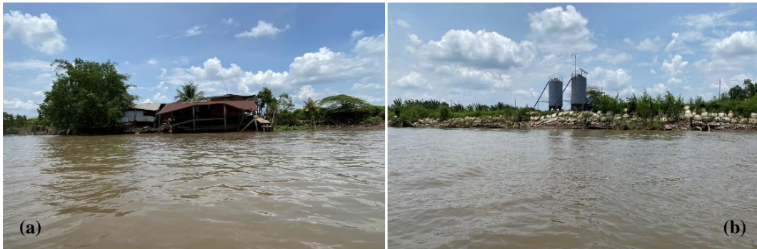
Hình 10. Hình ảnh sạt lở bờ sông cồn Thanh Long (KV. 3): (a, b) Khu vực nhánh phải.
